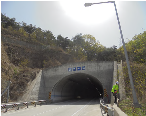
5공구 불로터널(영천방향) (5공구) 시점부
