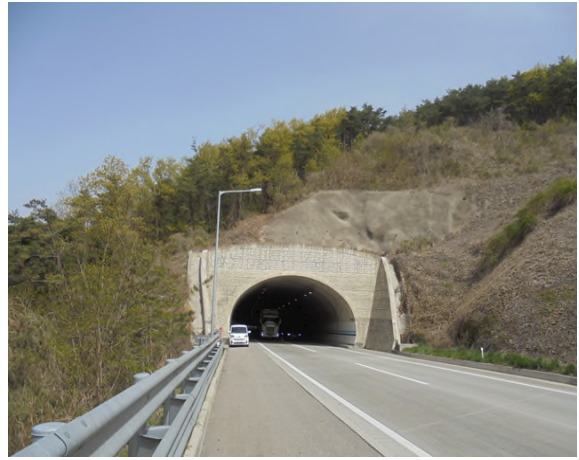
4공구 산법터널(영천방향) (4공구) 종점부
