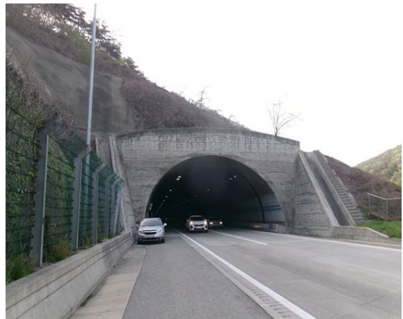
4공구 평호터널(상주방향) (4공구) 종점부
