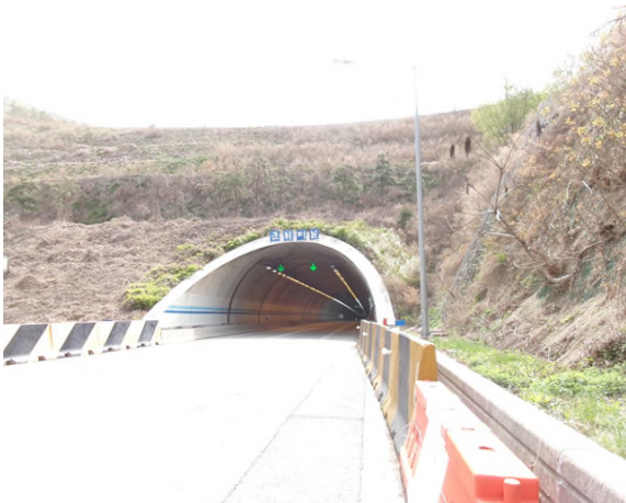
3공구 군위터널(영천방향) (3공구) 시점부
