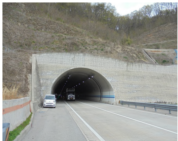
5공구 효령터널(영천방향) (5공구) 종점부
