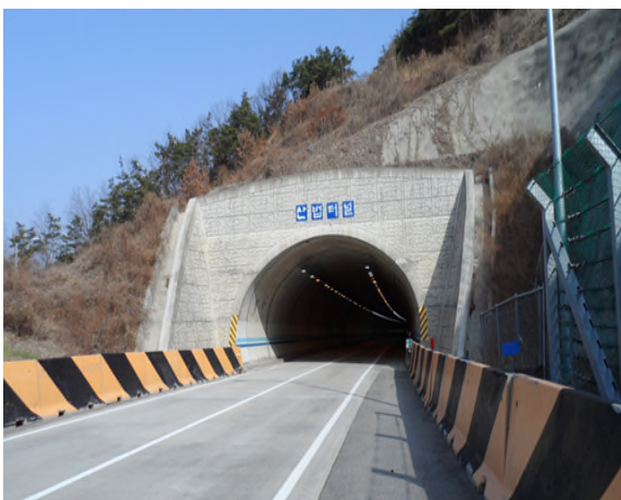
4공구 산법터널(상주방향) (4공구) 시점부
