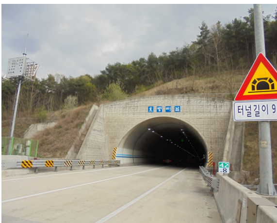
5공구 효령터널(영천방향) (5공구) 시점부
