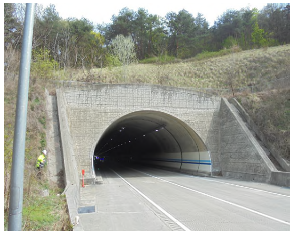
5공구 효령터널(상주방향) (5공구) 종점부
