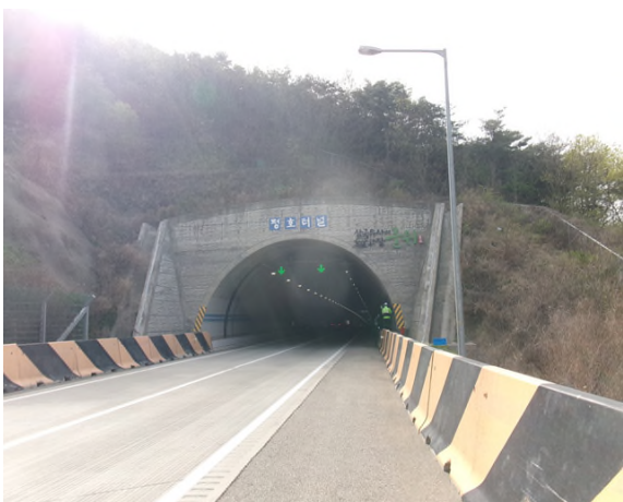
4공구 평호터널(영천방향) (4공구) 시점부
