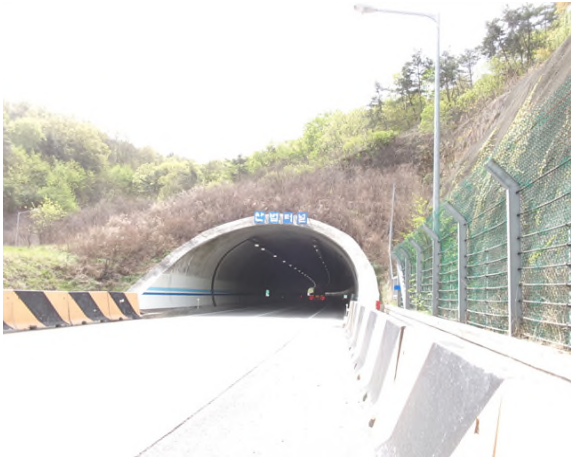
4공구 산법터널(영천방향) (4공구) 시점부
